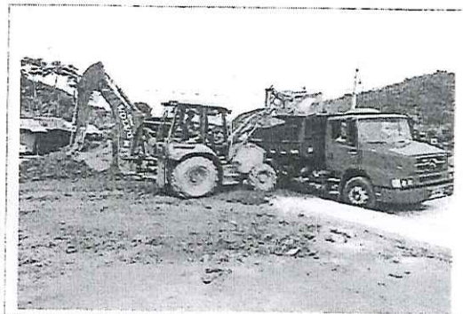
ESCAVAÇÃO E CARGA MECANIZADA EM MATERIAL DE 1ª CATEGORIA
