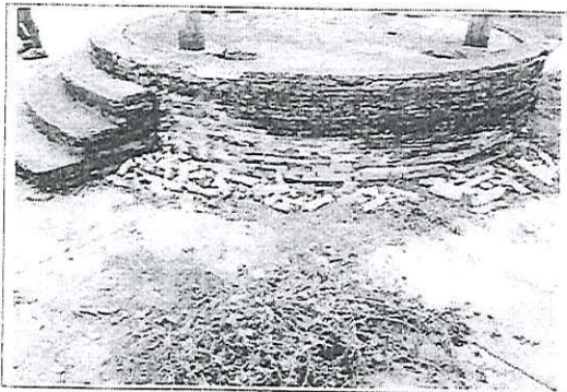
DEMOLIÇÃO DE PISO DE PEDRAS (MÁRMORE, GRANITO, ARDÓSIA, LAGOA SANTA, SÃO TOMÉ), INCLUSIVE AFASTAMENTO
