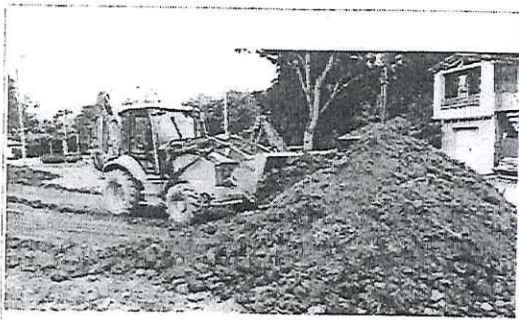
ESCAVAÇÃO E CARGA MECANIZADA EM MATERIAL DE 1ª CATEGORIA
