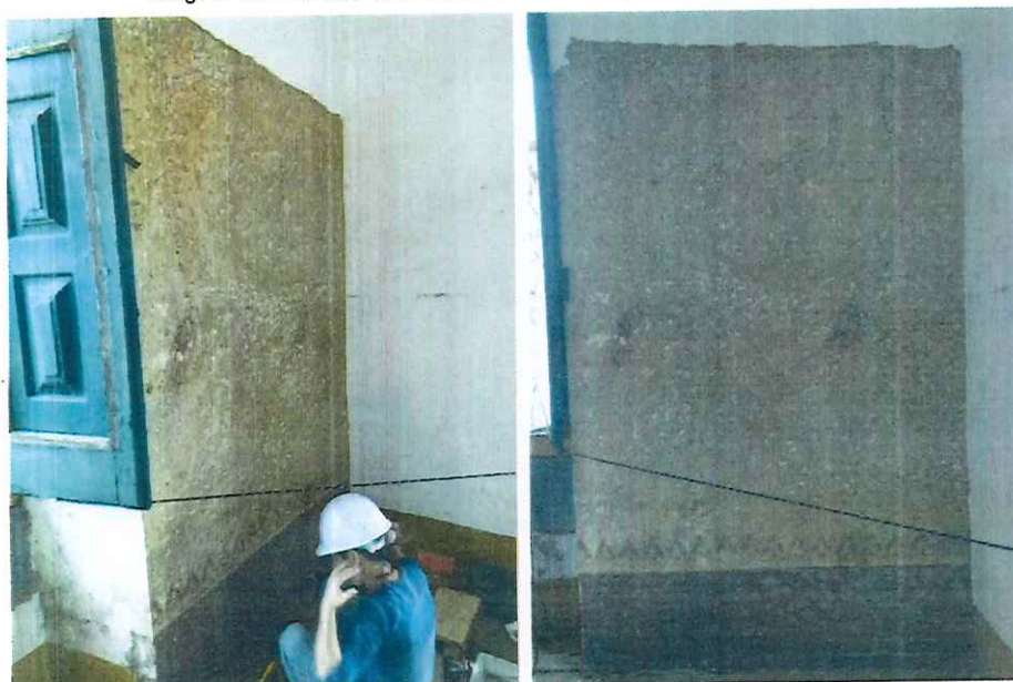
Imagens 15 e 16: Detalhamento nas pinturas reveladas através de remoção de reboco na sala de reuniões.
