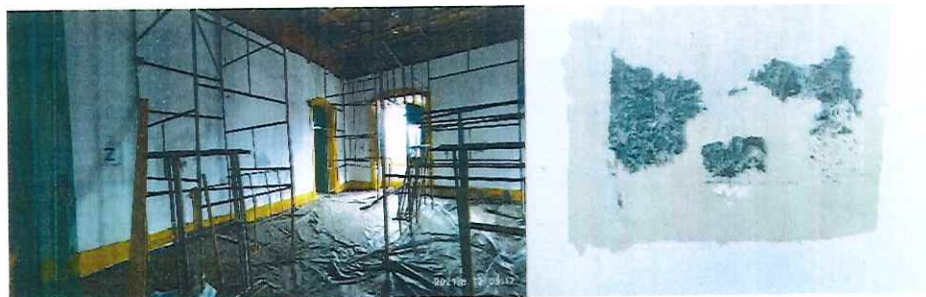
Imagens 12 e 13: Detalhamento nas pinturas reveladas através de prospecções estratigráficas na sala do plenário.
