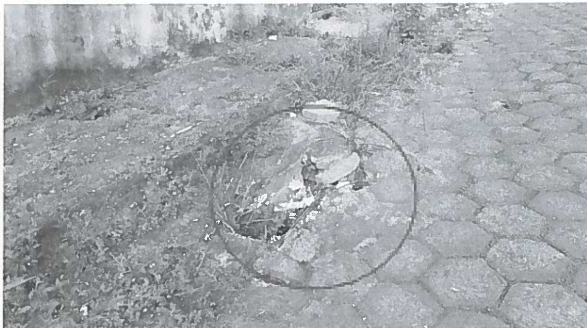
Registro atual do bueiro. 24/04/2023
