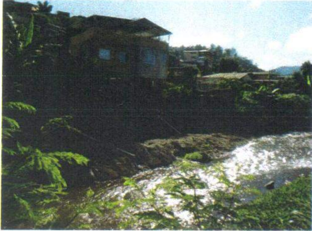
Foto 5.66 – Lançamento de esgoto in natura no Ribeirão do Carmo
