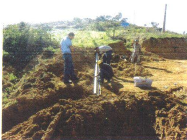
Foto 5.64 – Implantação da rede de abastecimento no subdistrito Barro Branco (1)
