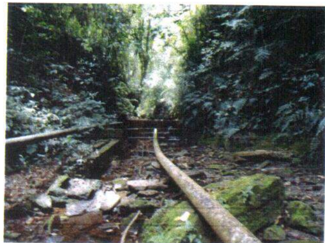
Foto 5.6 – Adutora do sistema (2)
