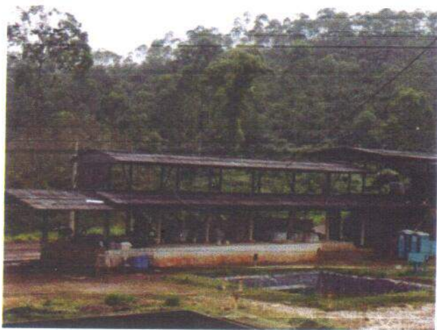
Foto 5.76 – Vista da usina de triagem desativada do Aterro Sanitário Municipal
