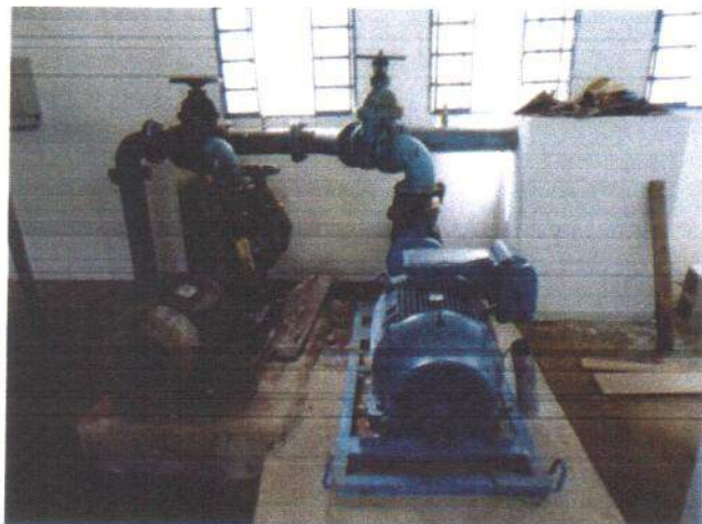
Foto 5.21 – EE ETA Seminário
