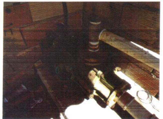
Foto 5.34 – EE ETA Matadouro
