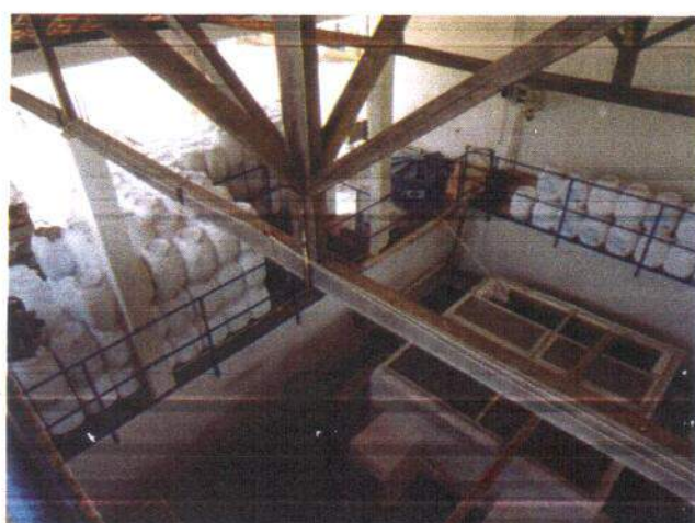
Foto 5.49 – Produtos químicos da ETA Sul
