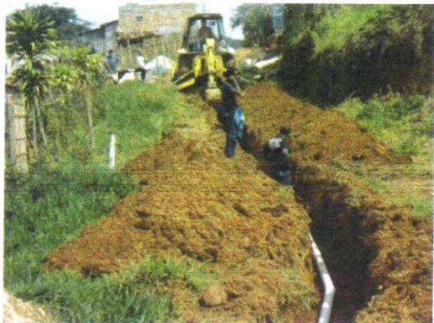
Foto 5.60 – Implantação da rede de abastecimento no Distrito Cláudio Manoel (1)
