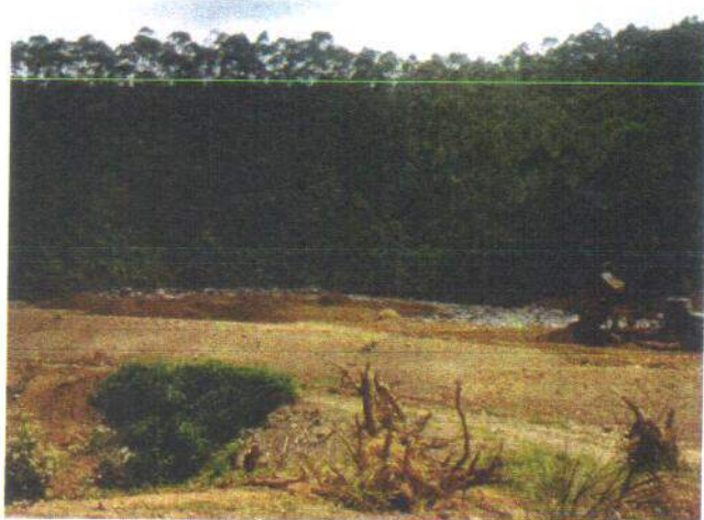
Foto 5.74 – Vista do Aterro Sanitário Municipal de Mariana
