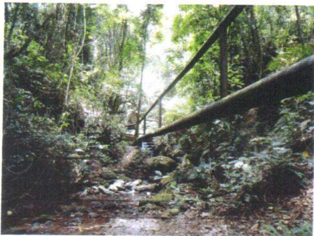
Foto 5.5 – Adutora do sistema (1)
