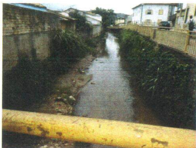
Foto 5.110 – Rua do Seminário (1)
