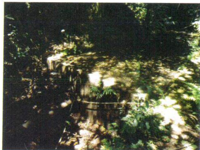
Foto 5.10 – Captação no Córrego Del Rey (2)
