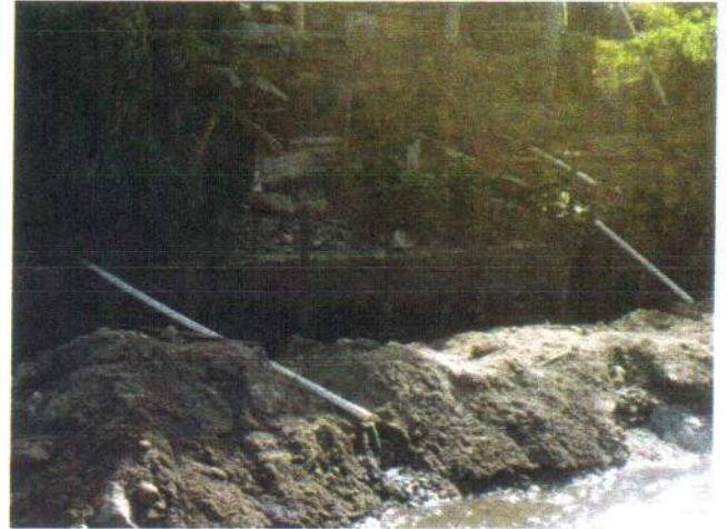
Foto 5.67 – Lançamento de esgoto in natura no Ribeirão do Carmo
