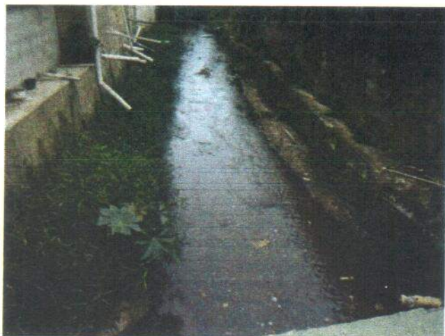
Foto 5.70 – Lançamento de esgoto in natura em afluente Ribeirão do Carmo
