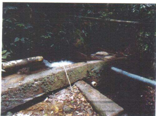
Foto 5.3 – Barragens de nível (1)
