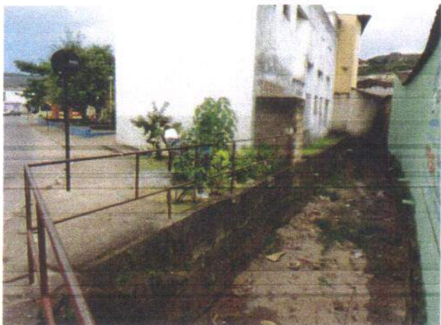
Foto 5.104 – Canal próximo à Praça do Barro Preto
