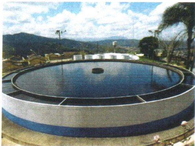
Foto 5.38 – Floco-decantador
