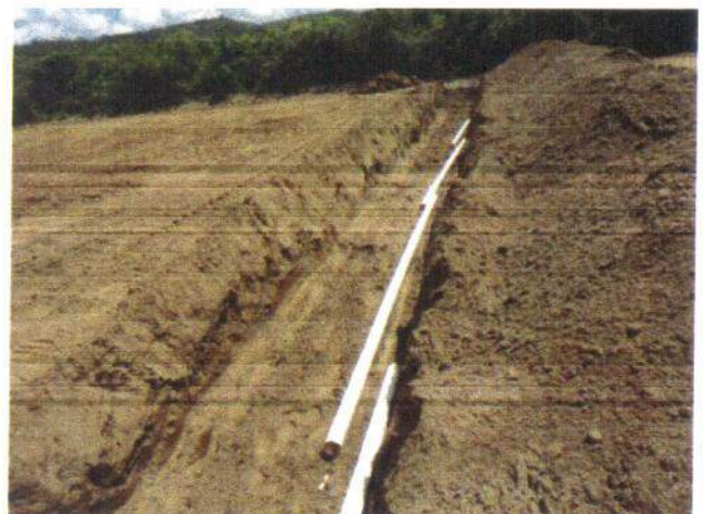
Foto 5.55 – Implantação da rede de abastecimento no Distrito Bandeirantes
