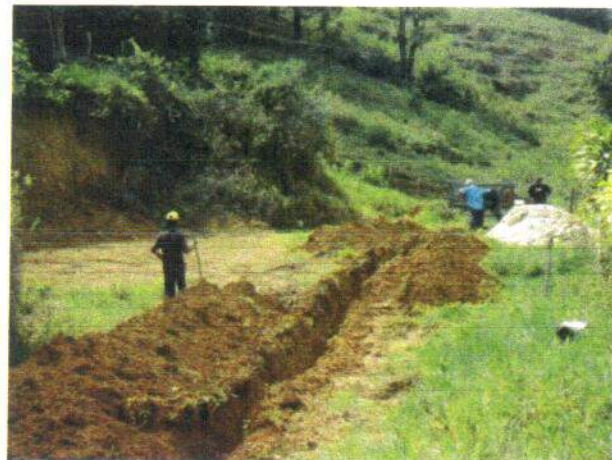
Foto 5.61 – Implantação da rede de abastecimento no Distrito Cláudio Manoel (2)
