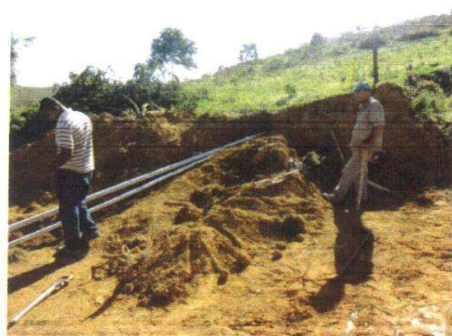
Foto 5.65 – Implantação da rede de abastecimento no subdistrito Barro Branco (2)
