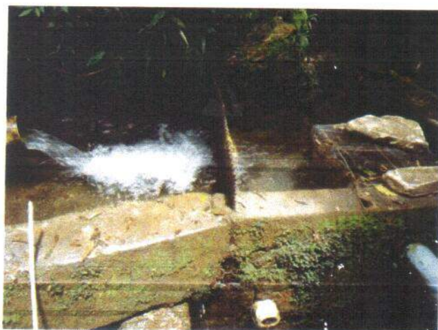
Foto 5.4 – Barragens de nível (2)
