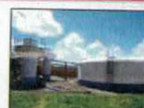
Reservatório ETA Santa Rita de Cássia
