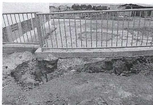
Fig.14- Necessidade de muro de contenção
