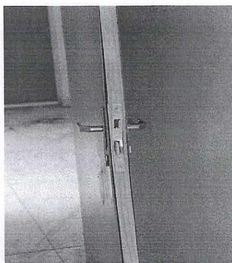
Fig.03- Fechadura danificada
