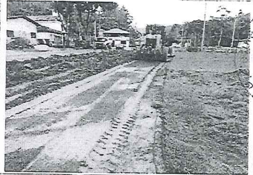
DESMATAMENTO E LIMPEZA MECANIZADA DE TERRENO COM REMOÇÃO DE CAMADA VEGETAL, UTILIZANDO TRATOR DE ESTEIRAS
