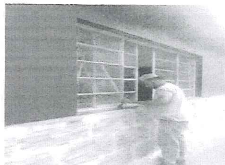
Imagem 38 – Pintura dos recortes da janela
