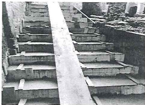
Imagem 7 – Execução da escada de acesso a lavanderia
