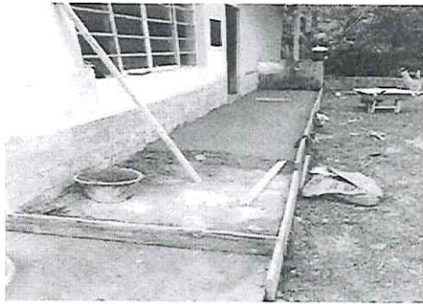
Imagem 8 – Execução de passeio ao redor da edificação
