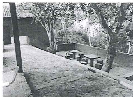
Imagem 56 – Instalação de grama na área externa e finalização da pintura
