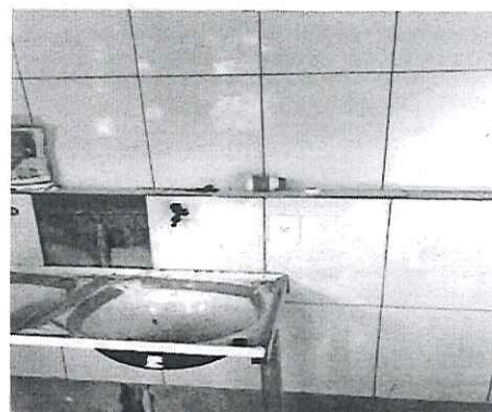
Imagem 46 – Instalação de revestimento cerâmico
