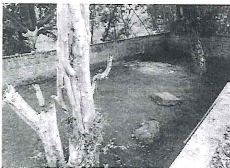
Imagem 1 – Limpeza do terreno
