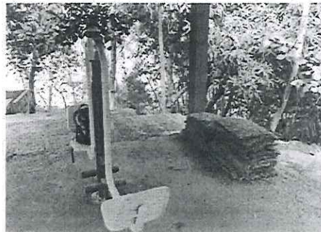
Imagem 54 – Instalação de grama na área externa
