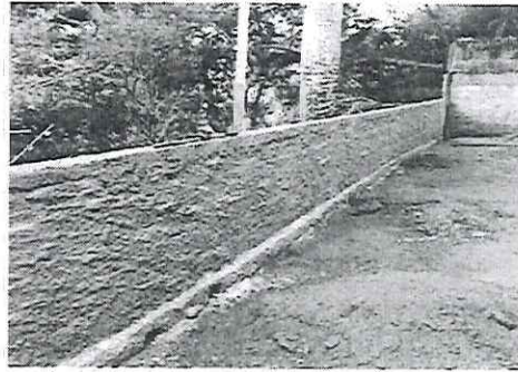
Imagem 6 – Iniciado o chapisco do muro
