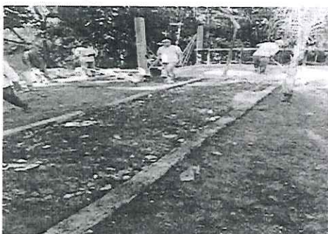
Imagem 13 – Compactação para o recebimento do contrapiso
