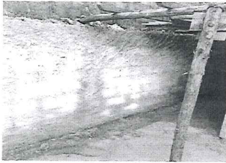
Imagem 5 – Execução de chapisco do muro
