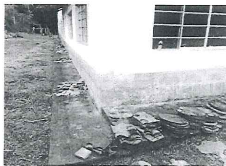
Imagem 2 – Retirada de revestimento das paredes
