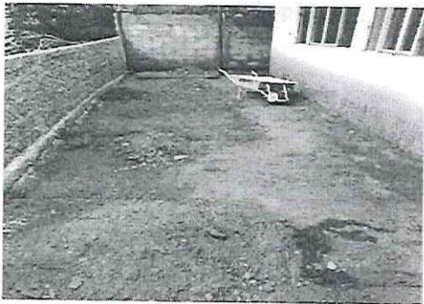
Imagem 11 – Chapisco do muro em fase de finalização
