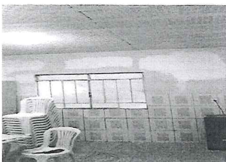
Imagem 31 – término da pintura interna
