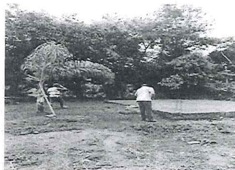
Imagem 4 – Limpeza do terreno
