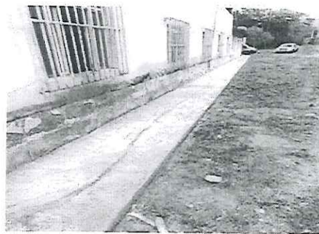
Imagem 10 – Finalização do passeio em volta da edificação
