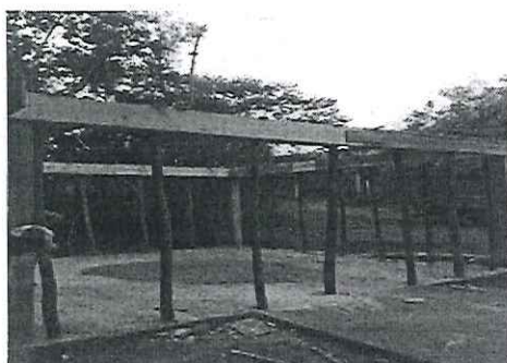
Imagem 20 – Forma de pilares e vigas aonde será a academia
