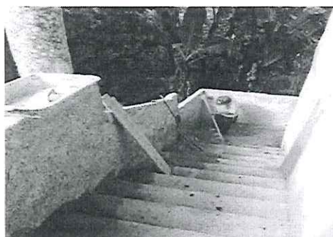
Imagem 49 - Execução do guarda corpo
