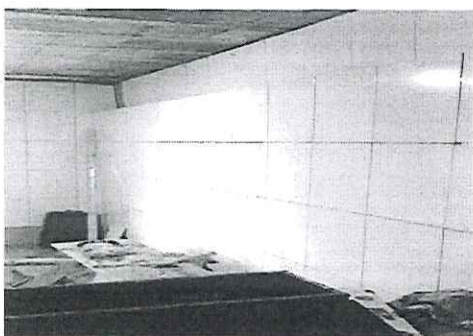
Imagem 29 – término do revestimento cerâmico da lavanderia
