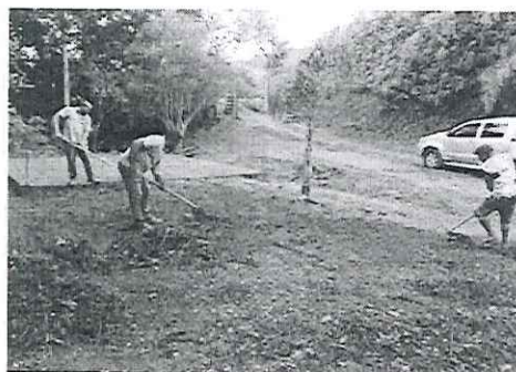
Imagem 3 – Limpeza do terreno
