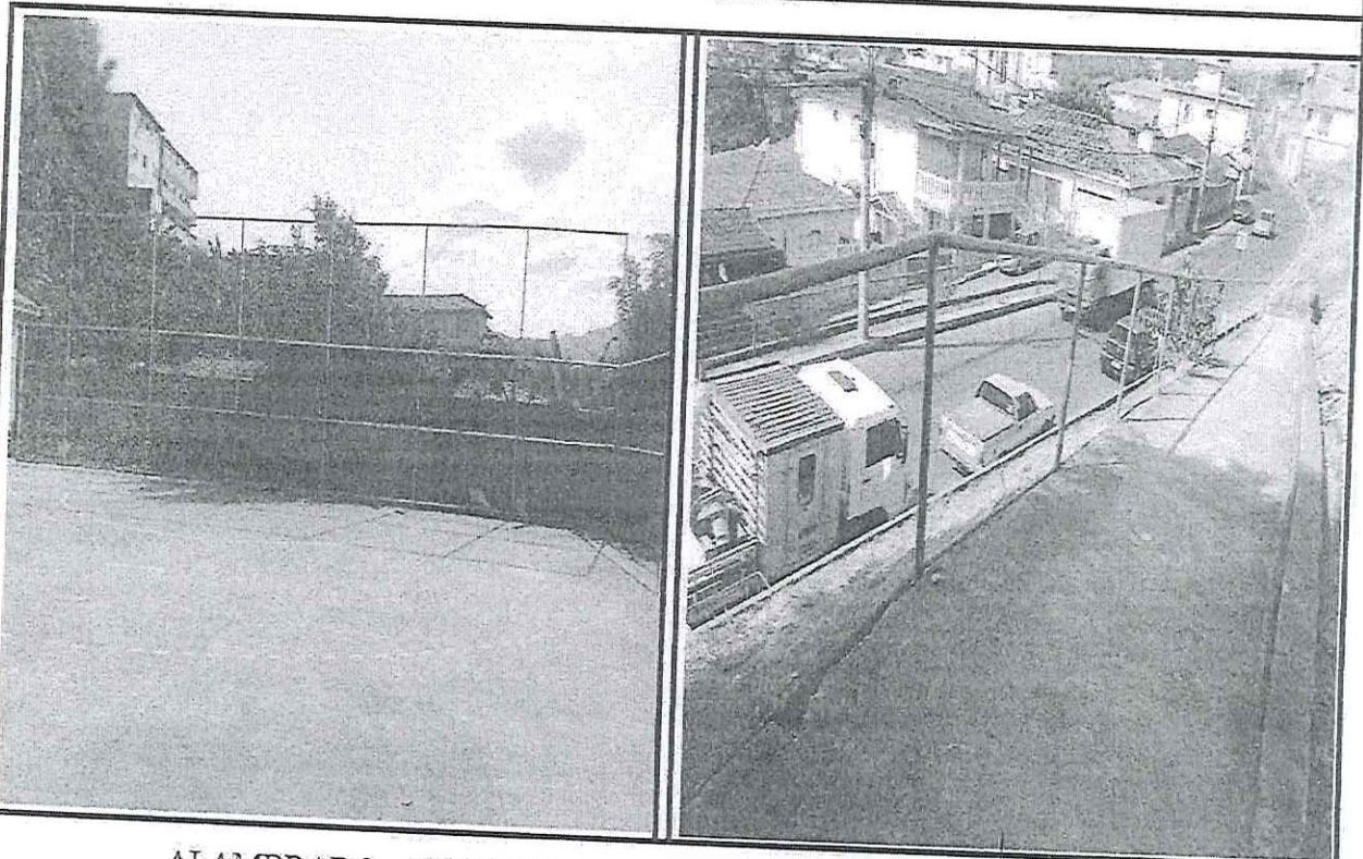
ALAMBRADO - QUADRA POLIESPORTIVA - BAIRRO SÃO PEDRO
