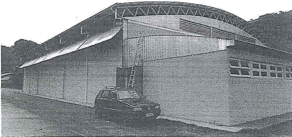
Calhas e condutores e reparo no telhado
