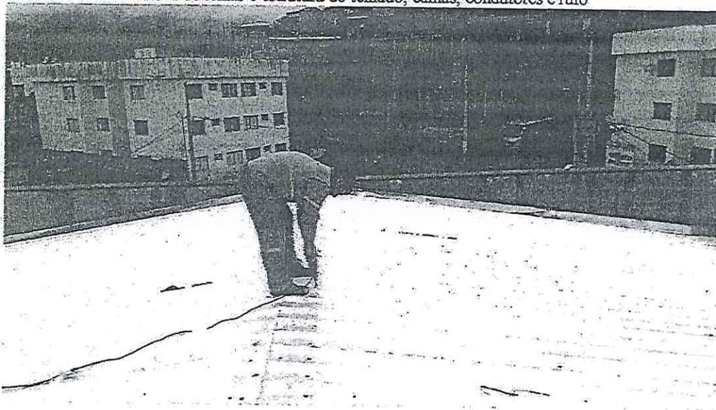
Troca de telhas e estrutura do telhado, calhas, condutores e rufo
